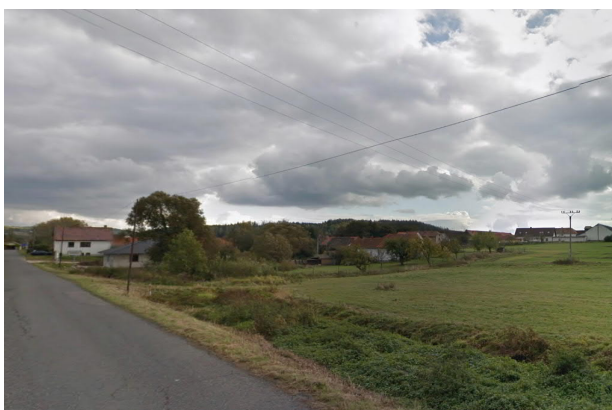
KB na Lhotském potoce na okraji zástavby obce Ouběnice (silnice od obce Ostrov)
