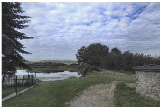
Hráz rybníka Nelibec v Suchodole - KB je umístěn mezi rybníkem Nelibec a Koryto
