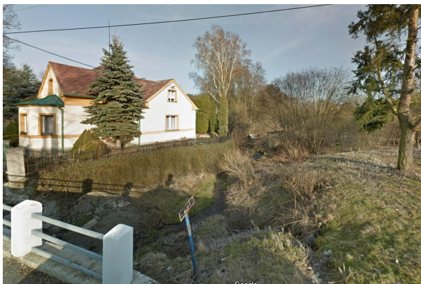
Pohled ze silničního propustku v obci Seněšnice do toku Makyty (nad KB)
