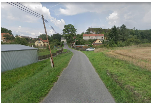
KB na bezejmenném pravostranném přítoku Kocáby na vtoku do zástavby obce Skalice
