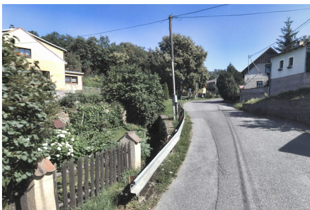
KB na drobném "severním" přítoku v zástavbě obce Velká Lečice
