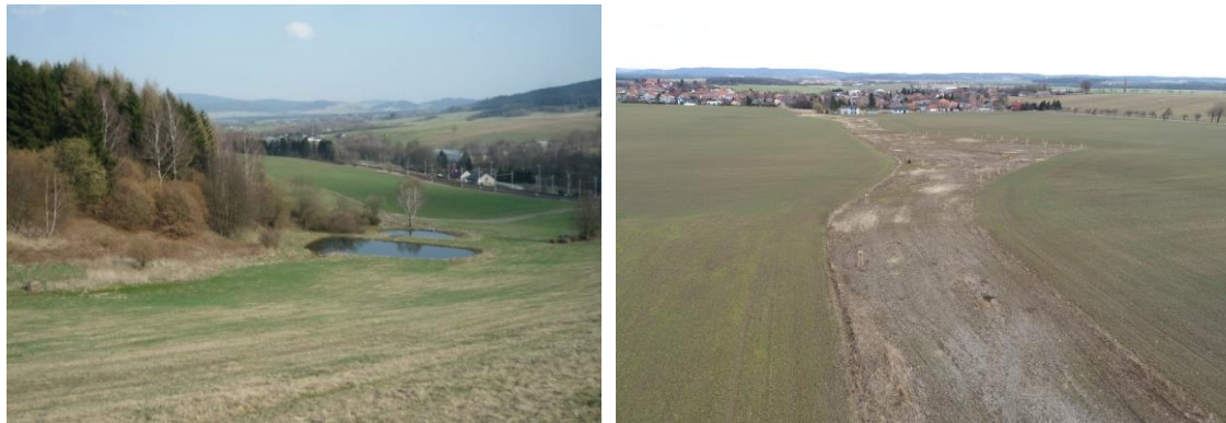
Obr. 4: Realizovaná opatření v ploše DSO v rámci KPÚ (foto SPÚ ČR, K. Vary), zatravněná údolnice u obce Rosovice, Středočeský kraj
