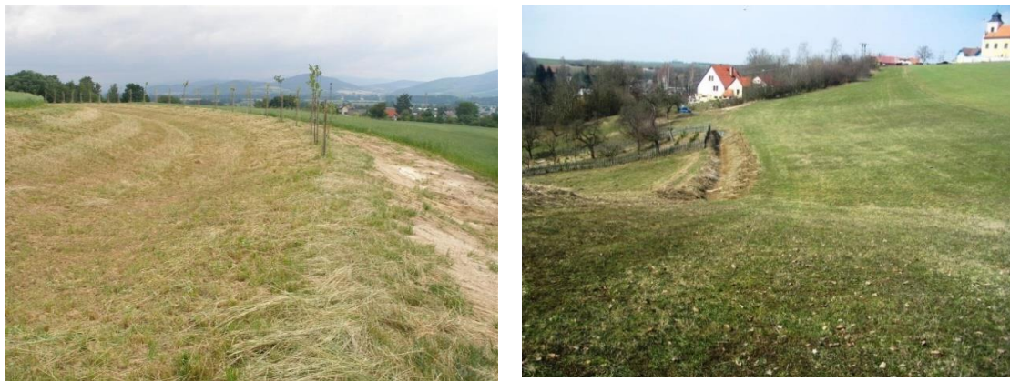
Obr. 1: Zatravněný retenční průleh u města Zábřeh na Moravě (zdroj http://www.zabreh.cz/ ), záchytný příkop nad pozemkem na okraji intravilánu obce
