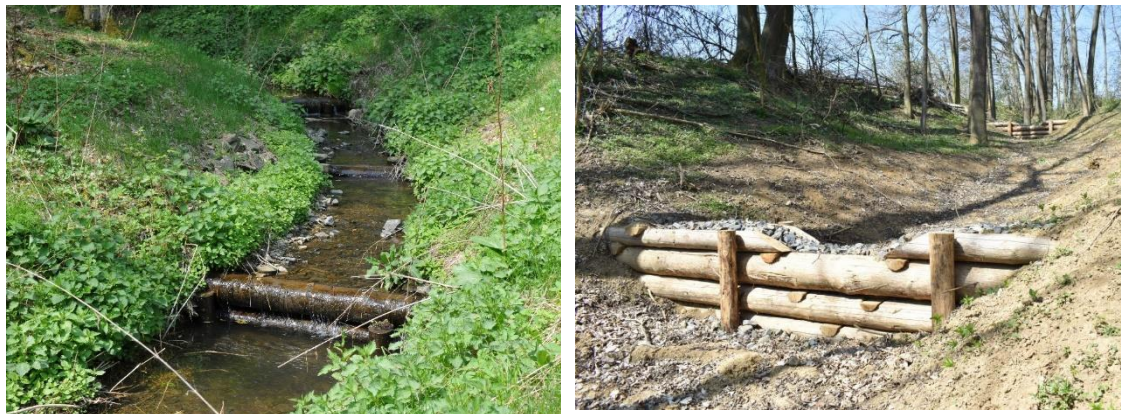
Obr. 9: Malý příčný objekt na Křivoklátsku a srubová přehrážka u Hradčan na Moravě (zdroj: Sweco, prerovsky.rej.cz)
