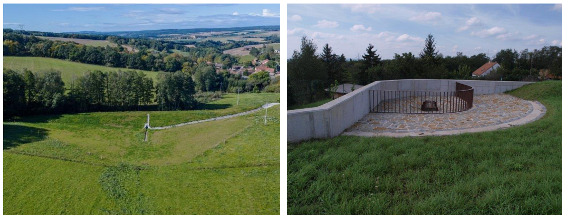
Obr. 12: Suchá nádrž Olešná u Radnic, malý retenční prostor Sobotnice (Zdroj: SPÚ)
