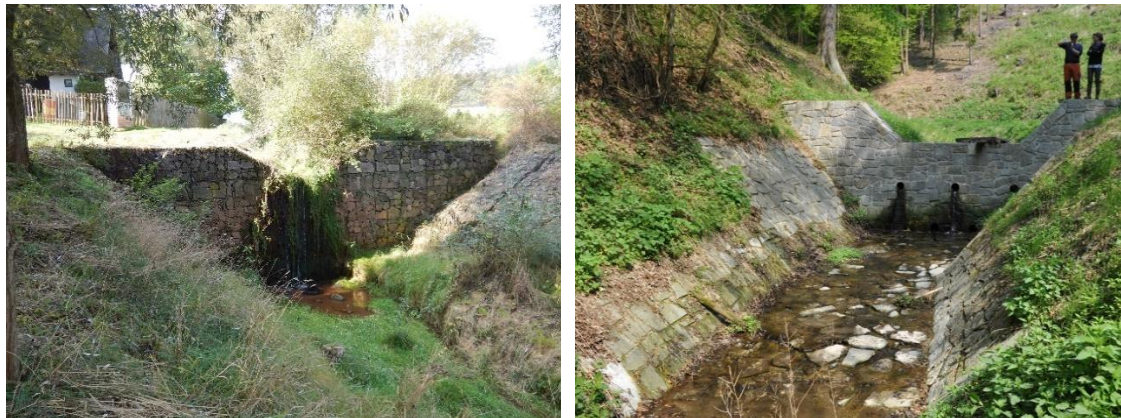
Obr. 8: Přehrážka u obce Domoušice v Ústeckém kraji, vpravo příklad lesní přehrážky na Křivoklátsku
