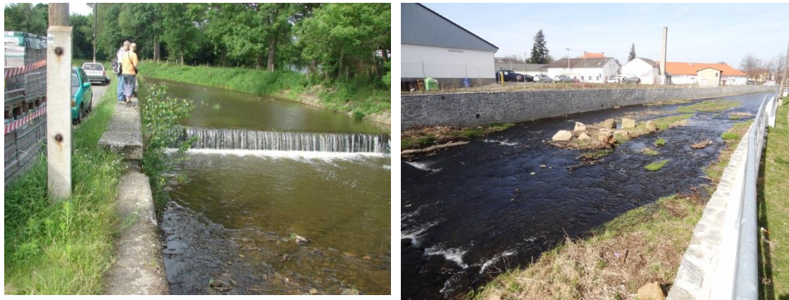
Obr. 11: Zprůchodnění úseku Červeného potoka v Hořovicích v rámci stavby PPO (odstranění spádového objektu a jeho nahrazení balvanitým skluzem s velmi pozvolným sklonem)
