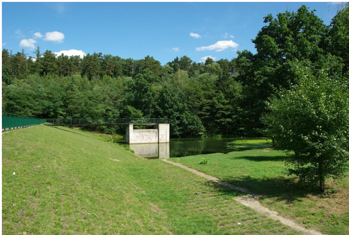
Obr. 6: Příklad retenční nádrže z Prahy – Modřan, sdružený objekt s dlužovou stěnou (zdroj: http://www.praha-priroda.cz/ )
