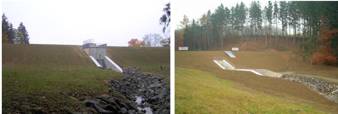
Obr. 3: Příklad realizované SN Čermná v Pošumaví (sdružený objekt, odtokové koryto)
