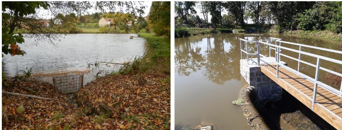
Obr. 7: Příklad malé vodní nádrže u Písku bez bezpečnostního přelivu a oproti tomu revitalizované nádrže na Jesenickém potoce ve Zdiměřicích
